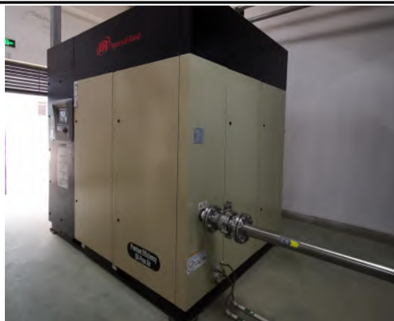
对空压机设置整体隔声罩及减震垫
