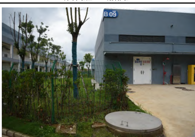
危废暂存间危废泄漏截留设施
