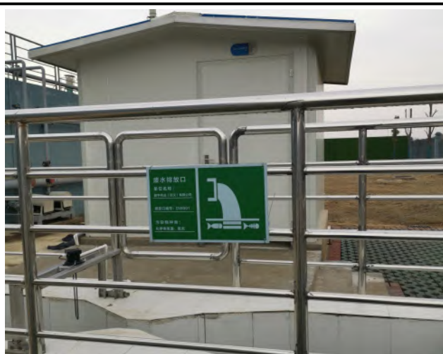
生产区废水处理站总排放口
