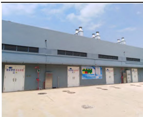
危险品库全貌及通风设施情况
