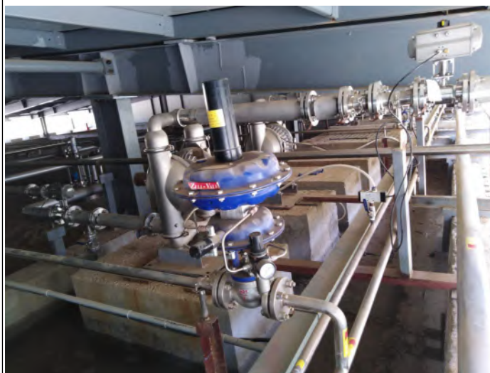
对各类泵管道连接处设置软连接
