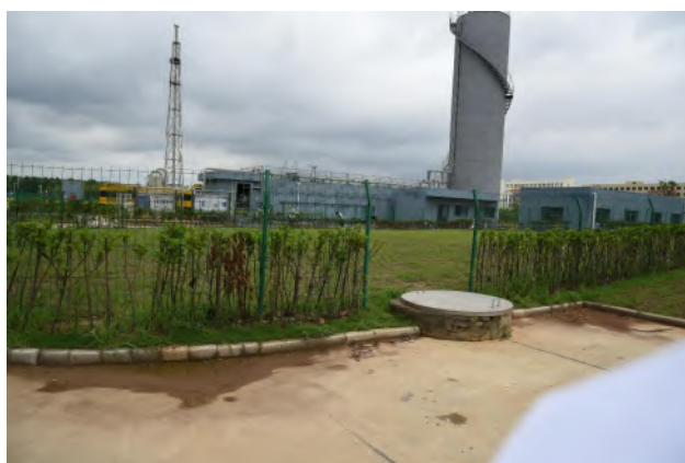
厂区事故应急池（1500m 3 ）
