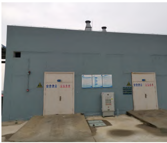
危废暂存间外景（设有警示牌及通风设施）
