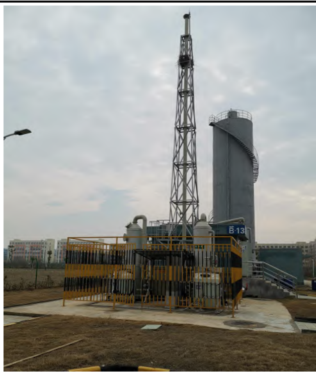
API 高浓度污水处理站
