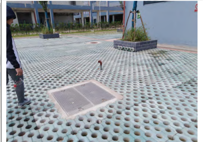
危险废物暂存间外配套防泄漏池
